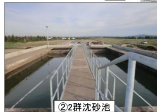
②2群沈砂池
