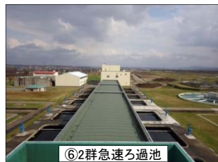
⑥2群急速ろ過池
