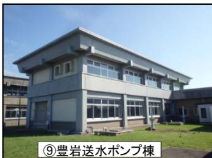
⑨豊岩送水ポンプ棟
