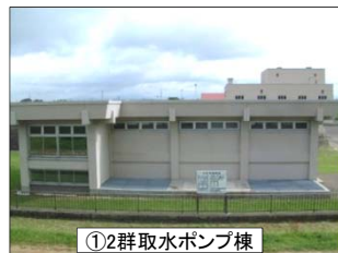
①2群取水ポンプ棟
