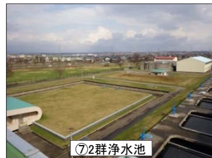
⑦2群浄水池
