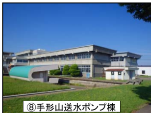
⑧手形山送水ポンプ棟
