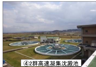
④2群高速凝集沈澱池
