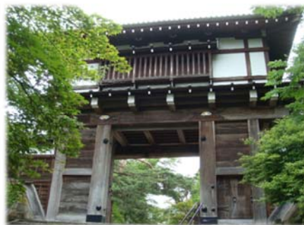
平成12年に復元整備された表門
