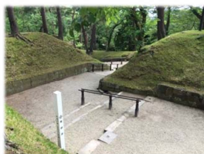
長坂の坂道改善策（手すりの設置）
