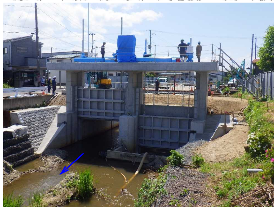
写真② 樋門本體工（大野橋から）
