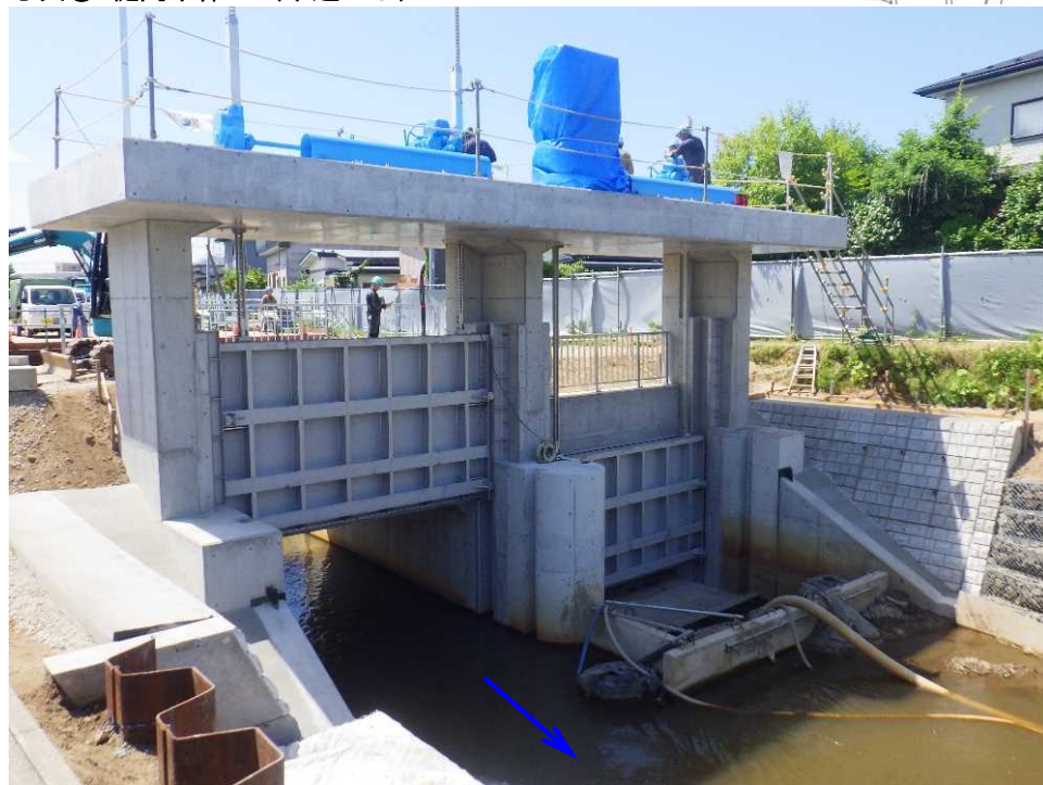
写真① 樋門本體工（市道から）
