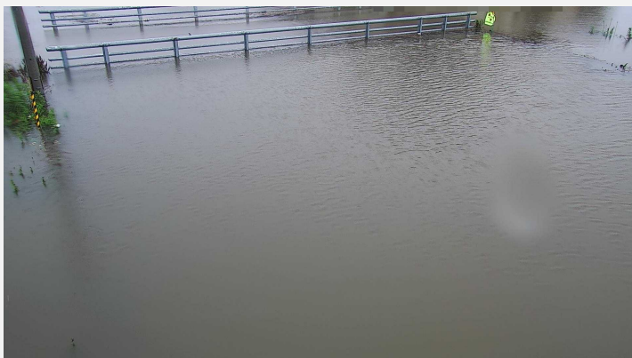
西潟敷一号橋
