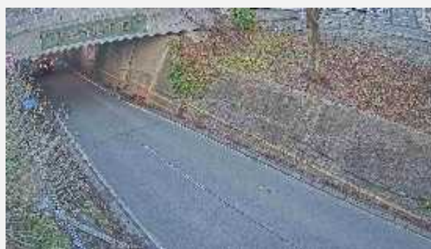
天徳寺地下道
