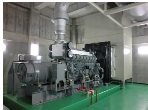
図 5-4 豊岩浄水場の自家用発電設備
