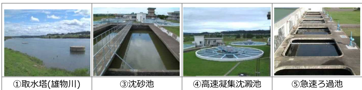
図 2-4 仁井田浄水場の浄水処理方式フロー
