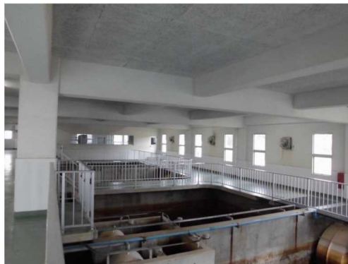
図5-5 テロ対策 (豊岩浄水場のろ過池上屋)
