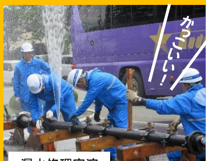
漏水修理実演
