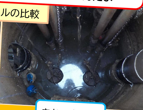
きれいな槽内
