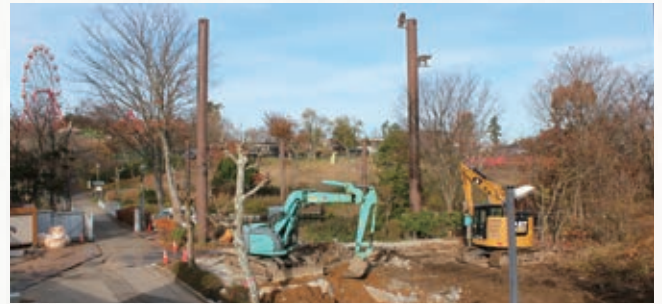
整備が進む新サル舎
