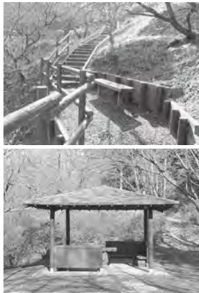
改修した園路(上)と東屋(下)
