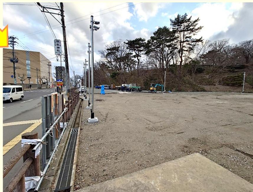
施工中（3月末完成予定）
