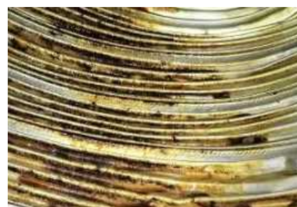
(フレキシブル排気ダクトの油脂付着状況)
