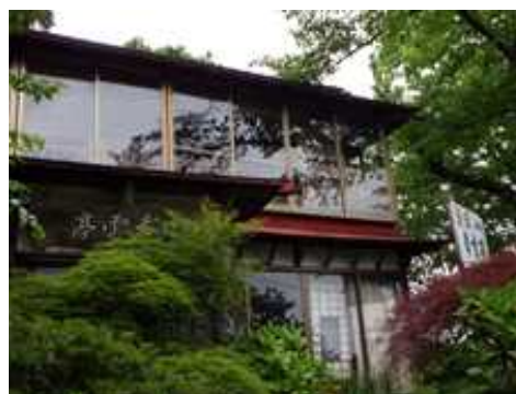
図2 対象施設近景
