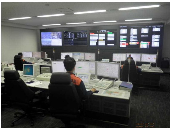
消防指令センター
