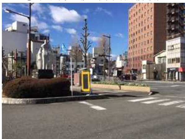
⑥路車掲示板 (中央前橋駅)
