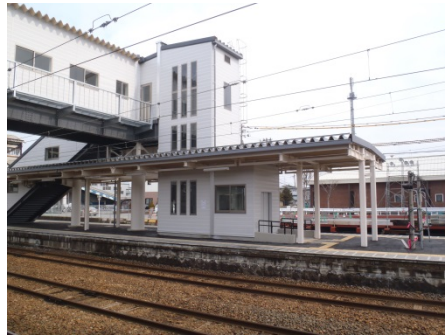
▲こ線橋の改築とともに、新たに設置されたエレベーター(上りホーム側)
