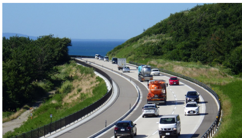
▲国道7号（下浜道路）の整備事例
