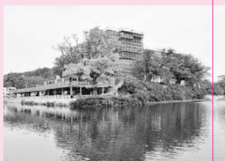
建設中の あきた芸術劇場
