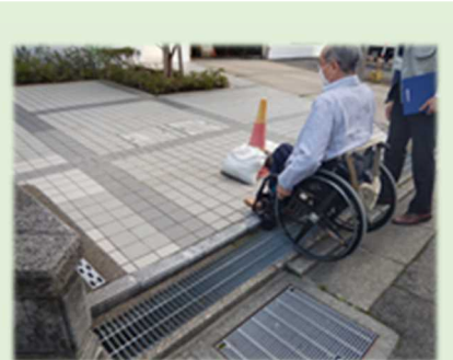
(歩道と駐車場敷地との段差)
