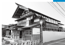
改修中の旧松倉家住宅
