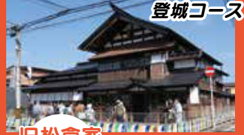
旧松倉家住宅 *修復工事中
