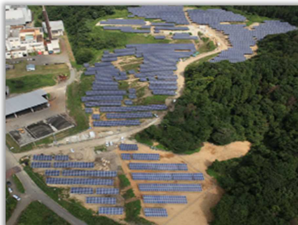
秋田市メガソーラー発電所
