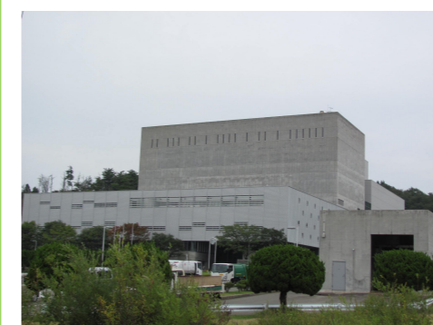
秋田市総合環境センター(溶融施設)
