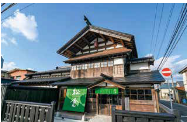
■3月 修復整備工事を終えた県指定有形文化財「旧松倉家住宅」が、町家の趣を残し新たなにぎわいの場としてオープン
