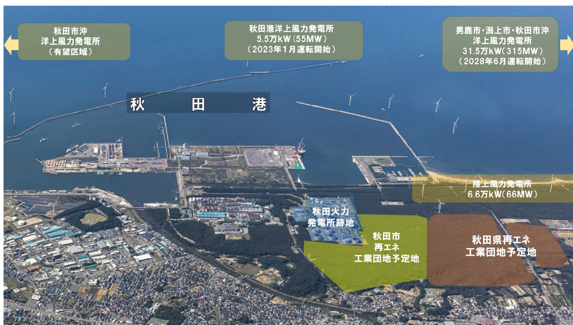
図 14 「北部地区再生可能エネルギー工業団地」候補地の周辺の様子
