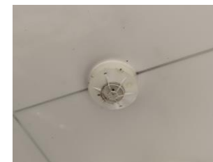
防火設備連動用感知器
