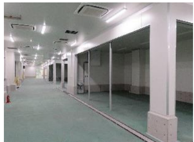
閉鎖化し、温度管理を徹底した売場
