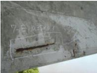
・鉄筋露出、腐食
