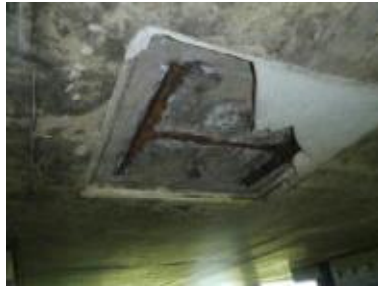
・鉄筋露出、腐食
