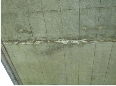
・鉄筋露出、腐食
