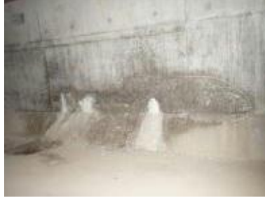
・鉄筋露出、腐食
