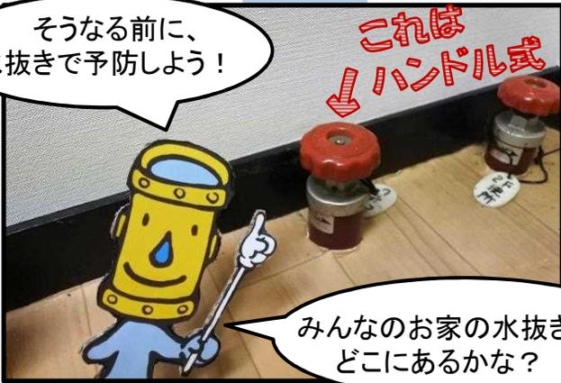
水道管の凍結を防ぐには、水抜き栓操作で
