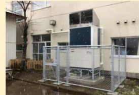
空調設備の基礎嵩上げ
