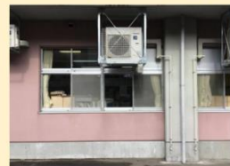
エアコン室外機を吊り下げ設置
