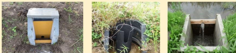
田んぼダムに対応した田面排水柵・水位調整板のイメージ
