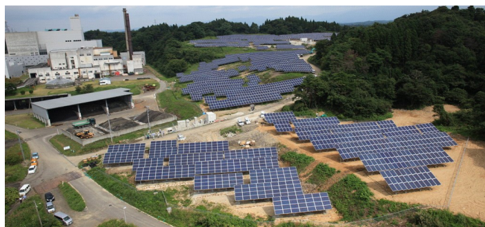
秋田市メガソーラー発電所
