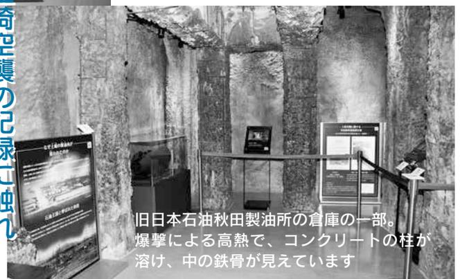
旧日本石油秋田製油所の倉庫の一部。爆撃による高熱で、コンクリートの柱が溶け、中の鉄骨が見えています
