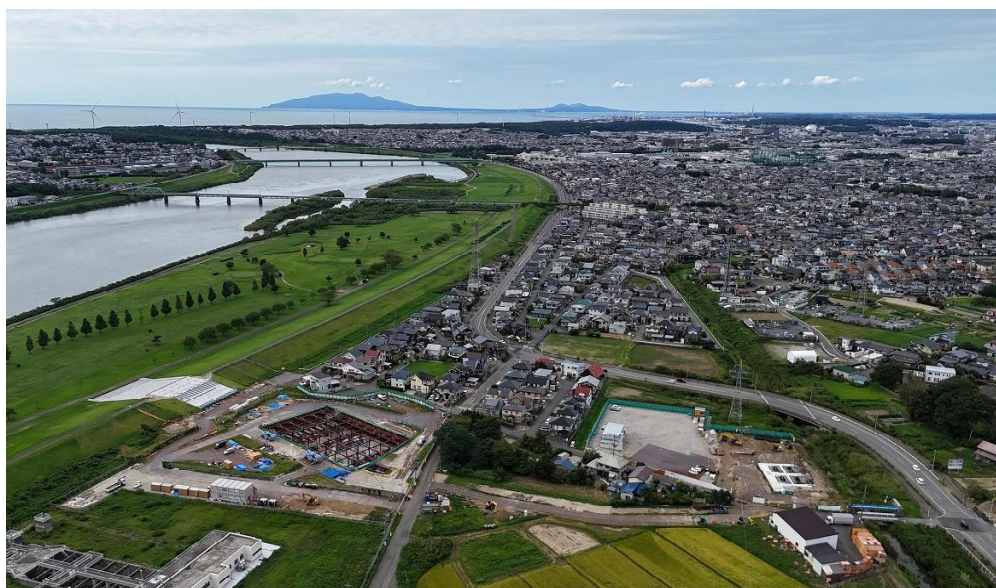
写真 古川雨水排水ポンプ場（令和7年8月31日撮影）
