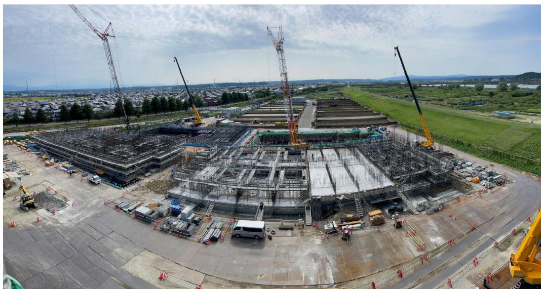
写真 仁井田浄水場等整備事業（令和7年8月26日撮影）
