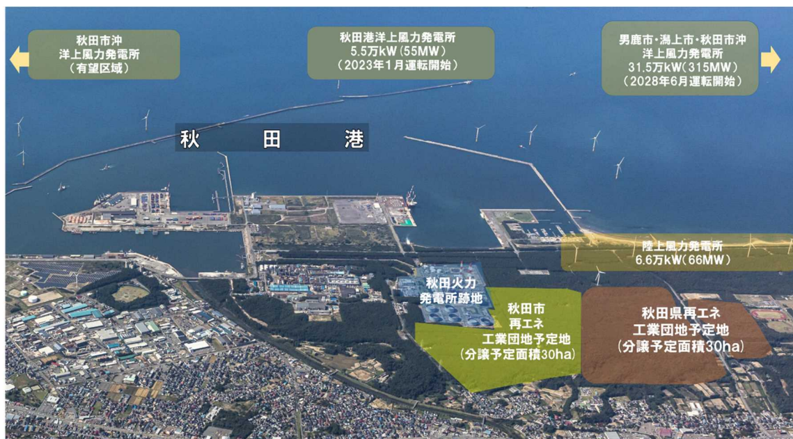
図 14 「北部地区再生可能エネルギー工業団地」候補地の周辺の様子
