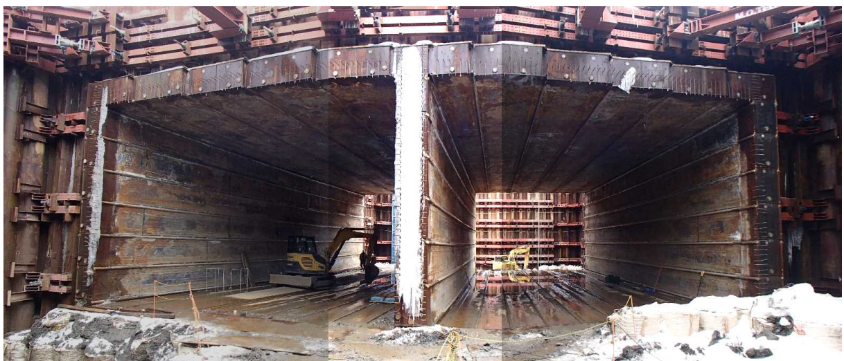
鋼製函体内部（東第三地区側）
