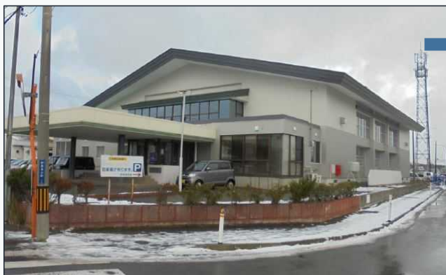
西部体育館 築39年 996.56㎡
