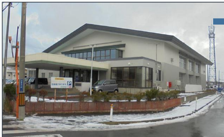
西部体育館 築39年 996.56㎡
