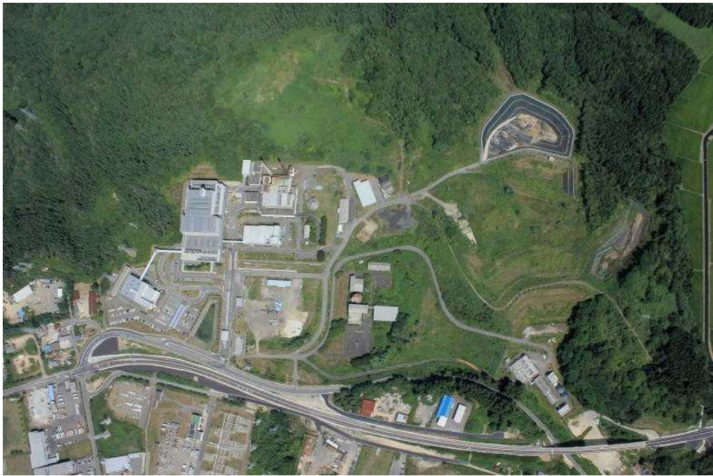
敷地全景写真（平成 18 年：第 2 リサイクルプラザ建設後）
