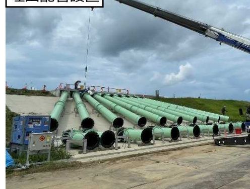
吐出配管設置
