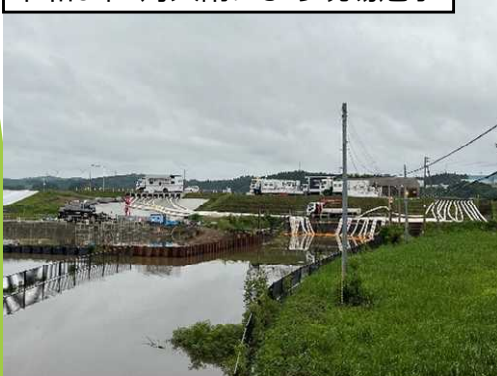
令和6年7月大雨により現場冠水
