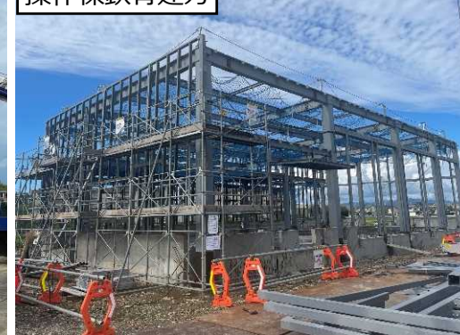
操作棟鉄骨建方
