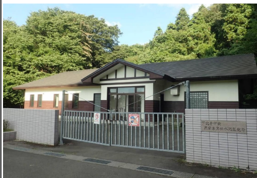
【下北手中央農業集落排水処理施設】
