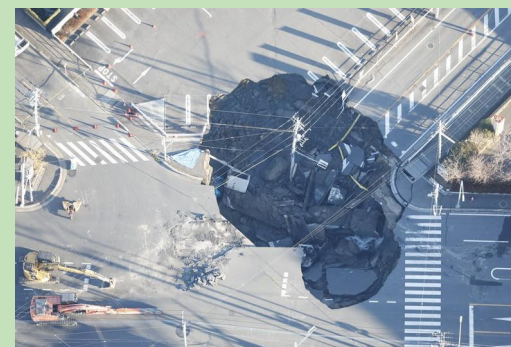
(八潮市の陥没事故)
