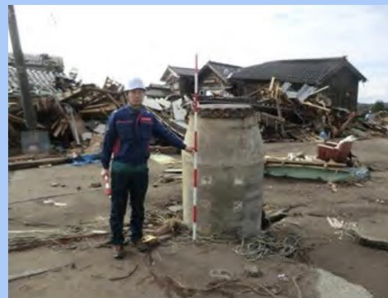
マンホール浮上の様子 (国土交通省国土技術政策総合研究所より)
