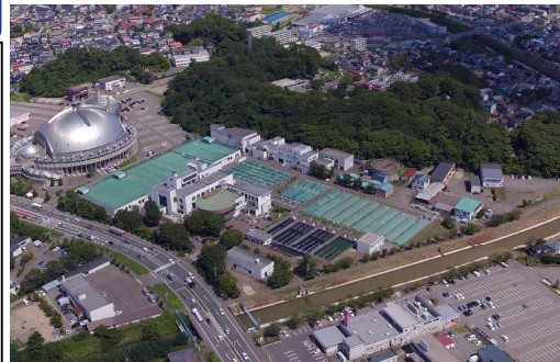
【八橋汚水中継ポンプ場】
