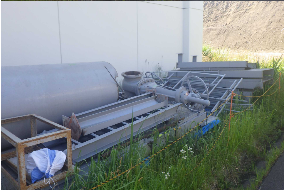
運搬箇所① 鉄屑類 弁、歩廊鋼材
