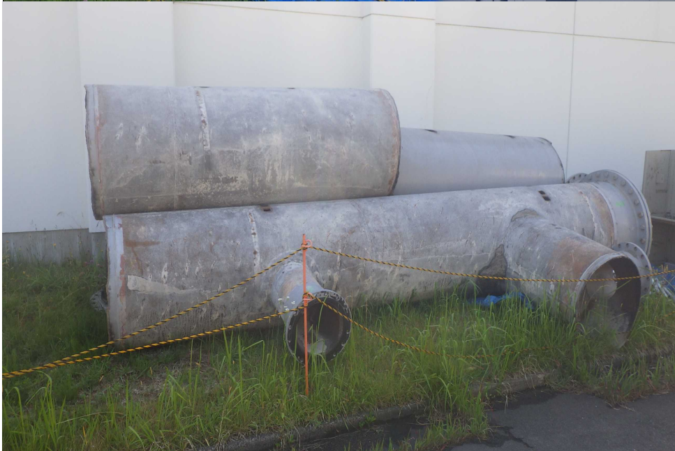
運搬箇所① 鉄屑類 配管
