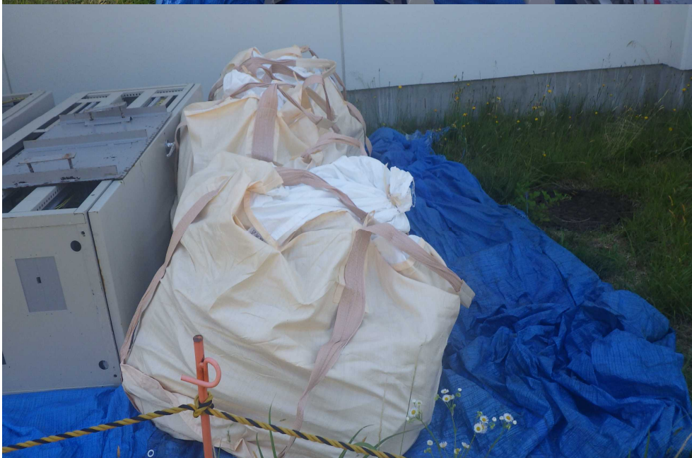
運搬箇所① ケーブル ※フレコン内、被覆付き
