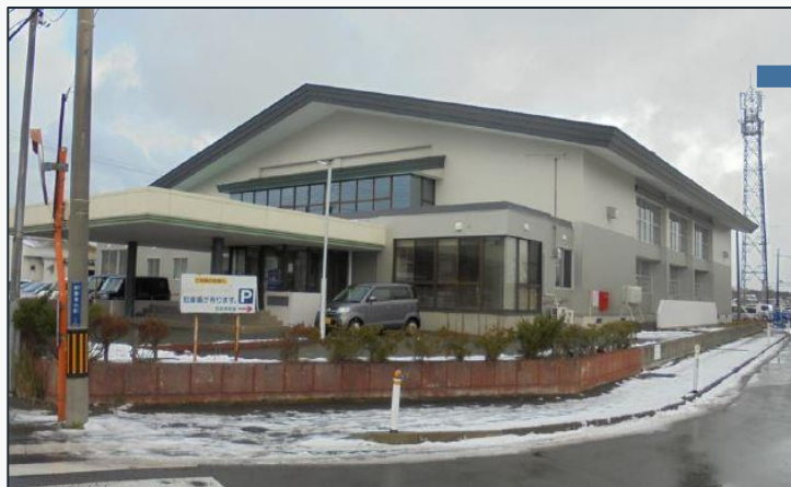
西部体育館 築39年 996.56㎡
