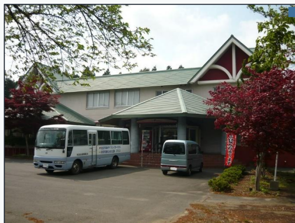
雄和サイクリングターミナル 築41年 1,414.08㎡
